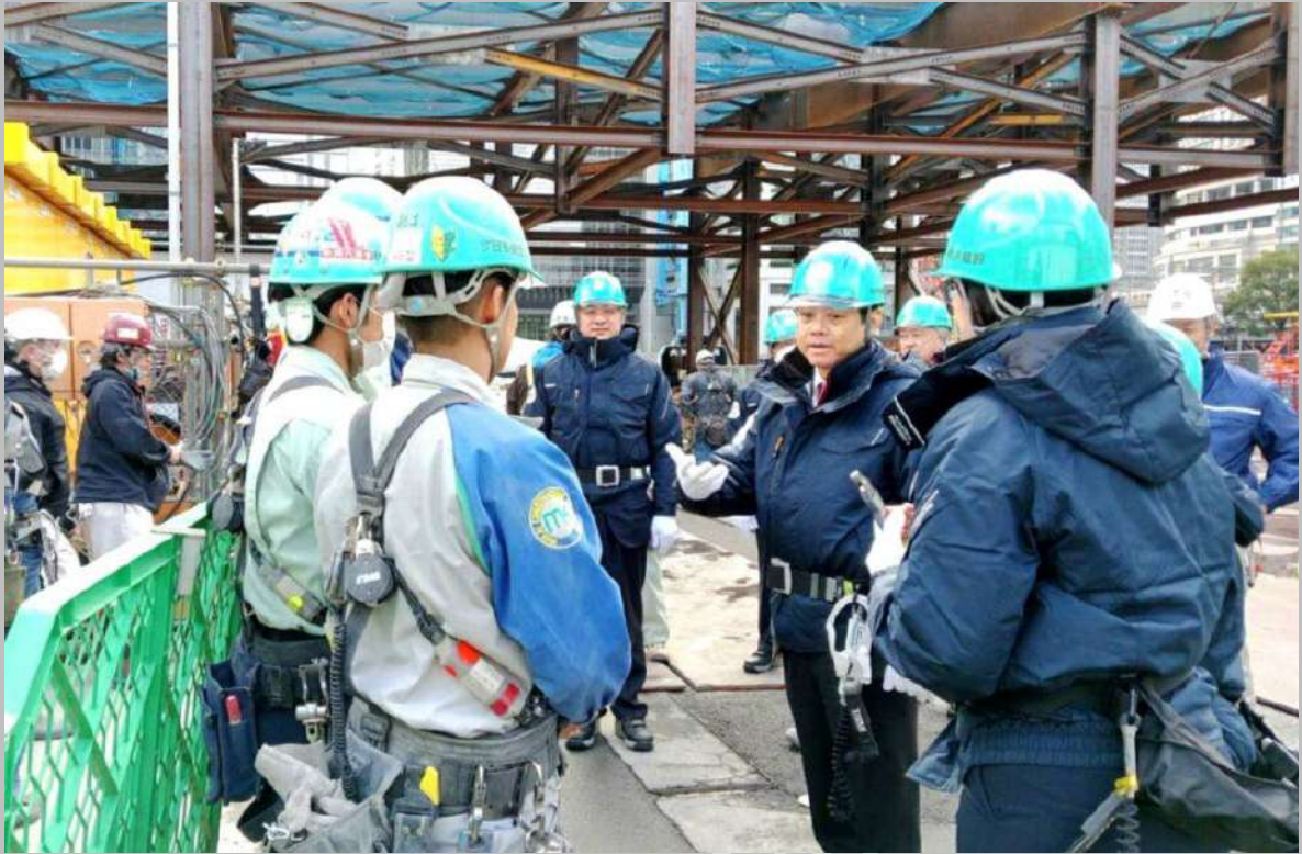
သံအမတ်ကြီးသည် တိုကျိုမြို့ရှိ Tokiwa Bridge ဆောက်လုပ်ရေးလုပ်ငန်းခွင်သို့သွားရောက်၍ မြန်မာနိုင်ငံမှ နည်းပညာအလုပ်သင် သင်တန်းသားများ ပါဝင်လုပ်ကိုင် ဆောင်ရွက်နေမှုကို လေ့လာကြည့်ရှု၍ အားပေးနှုတ်ဆက်စကားပြောကြားစဉ်။
